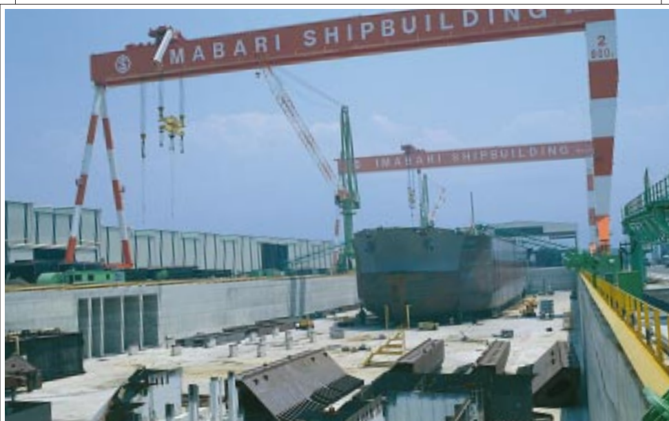
韓国や中国との競争に生き残るために西条工場（愛媛県西条市）の新ドック建設に踏み切った
